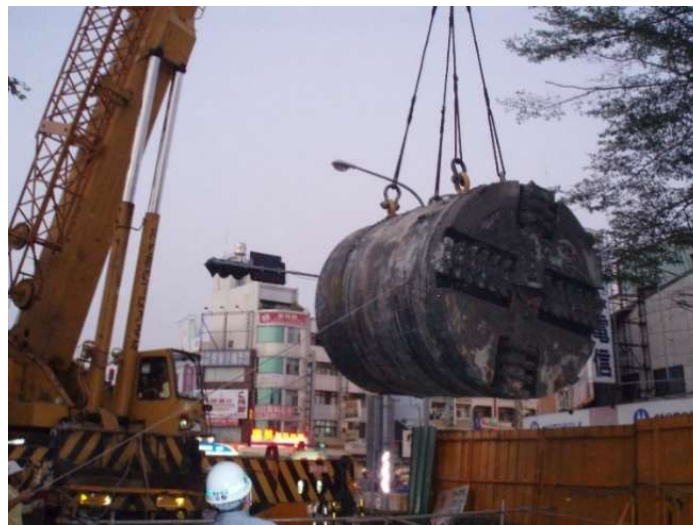
くっしん き てっきょ 掘進機撤去
