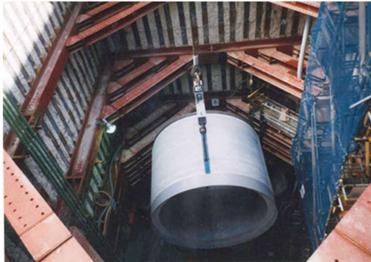
かん つり お 管の吊下ろし
